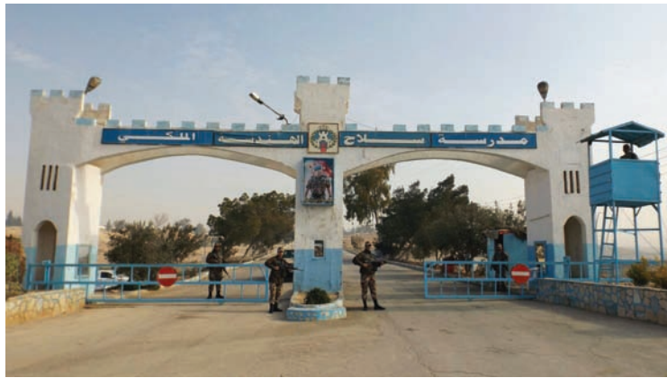
الشكل (٦-٩): مبنى مدرسة سلاح الهندسة الملكي.
