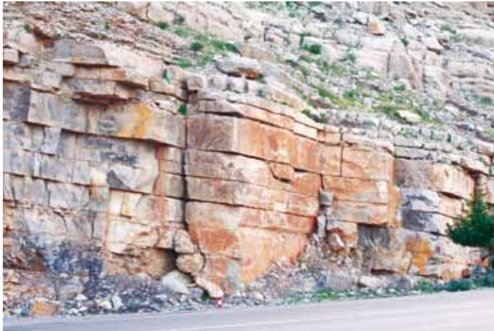
الشكل رقم (٣-١٢): الشقوق وأثرها في إضعاف الصخر.
