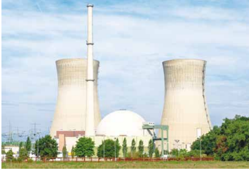
الشكل رقم (٢-١٨): محطة توليد الطاقة النووية.
